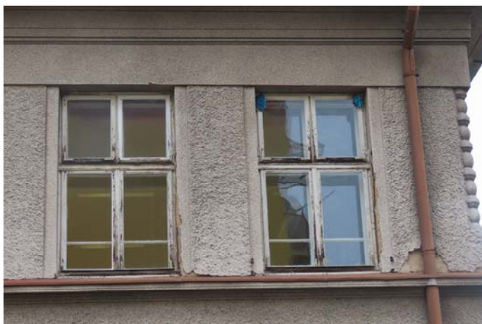
Okna z europrofilů v 1.NP – vyměněná
