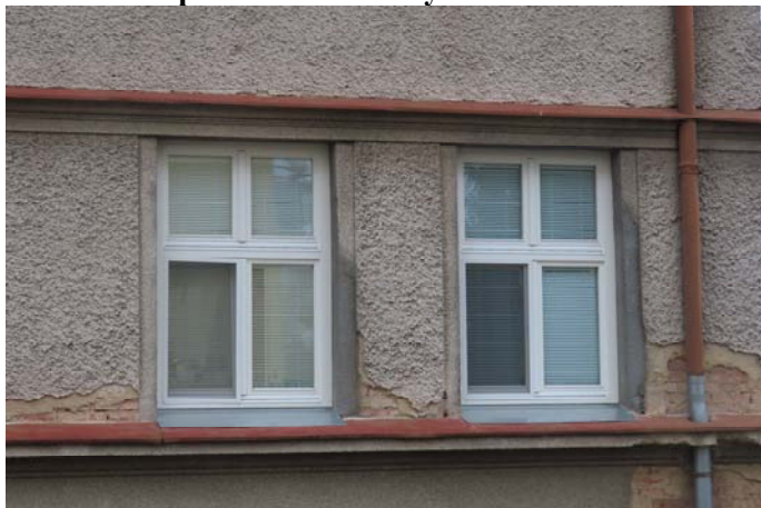
Okna z europrofilů v 1.NP – vyměněná
